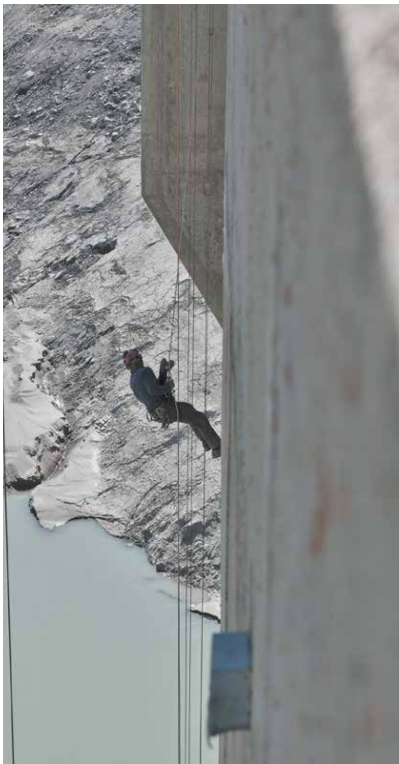
2015 haben wir die Erhöhungsarbeiten der Wasserfassung des Stausees Gries ausgeführt, welcher sich auf 2'387 m ü.M. befindet.
