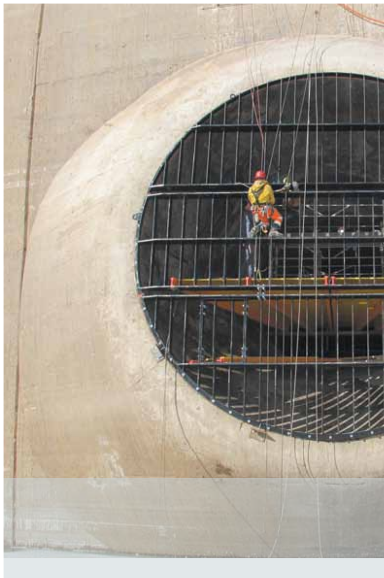
La réhabilitation des quatre groupes de pompage/turbinage de 60MW de la centrale de Veytaux et le remplacement des organes de sécurité de l'Hongrin se sont terminés en 2013.
