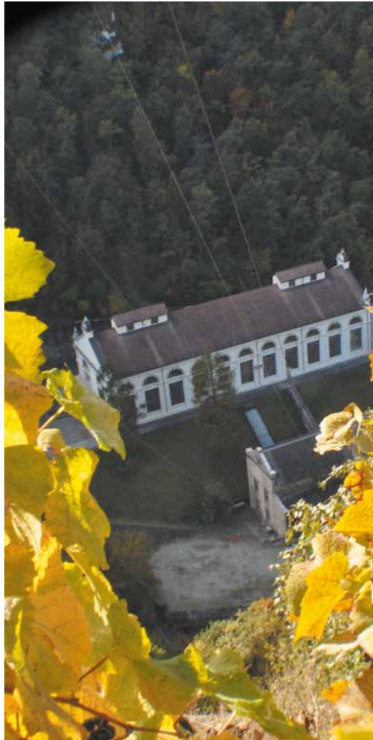
L'usine des Forces Motrices de la Borgne SA. Photo Christoph Pitteloud Das Werk der Forces Motrices de la Borgne SA. Foto Christoph Pitteloud
