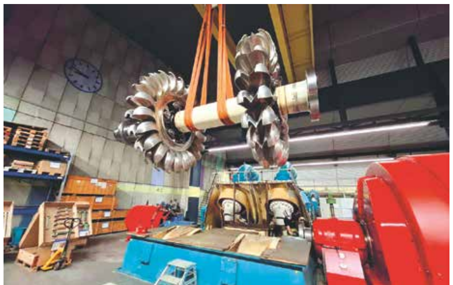
Remontage der Turbinenwelle. Remontage de l'arbre turbine.
