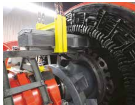
Démontage des dix pôles pour contrôle non destructif. Rückbau der zehn Pole für die zerstörungsfreie Prüfung.
