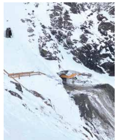
Die Reinigung des Zuflussschachts wurde bei winterlichen Bedingungen abgeschlossen. Le curage de la galerie d'adduction s'est terminé en conditions hivernales.
