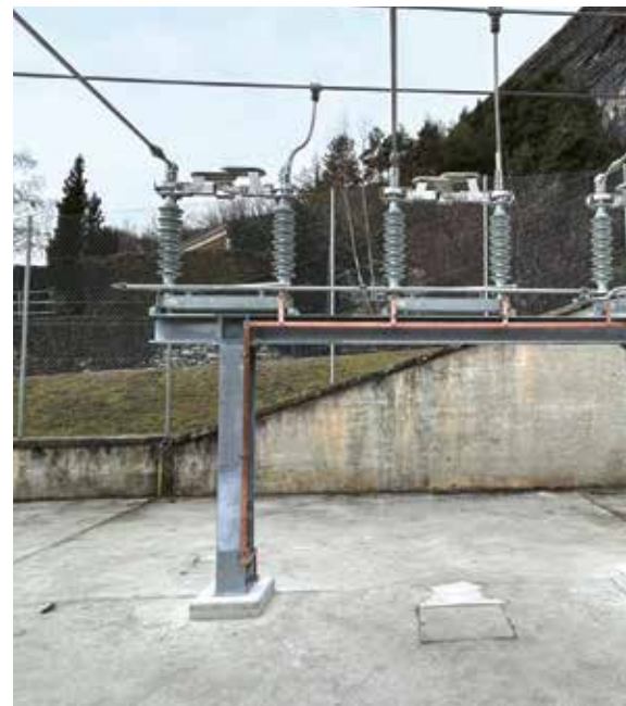
HYDRO a également réalisé la conception, le dimensionnement et l'exécution des huit nouveaux châssis métalliques et de leurs fondations.
