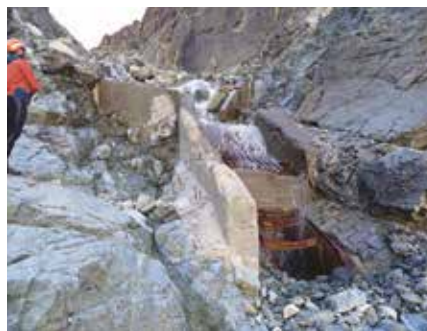
Mit den Arbeiten zur Instandsetzung und Reparatur der Wasserfassung wurde im Jahr 2025 begonnen, nachdem das Wasser in die untere Bertol-Wasserfassung umgeleitet wurde. Les travaux de remise en état de la prise d'eau ont débuté en 2025, après que les eaux aient été déviées vers la prise d'eau de Bertol inférieur.
