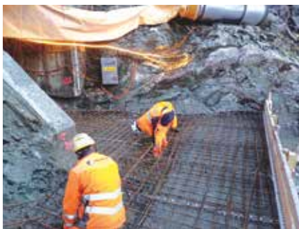
Une plateforme en béton armé a dû être construite pour permettre l'installation des machines de déblaiement (acheminées par hélicoptère Super Puma). Für das Aufstellen der Baggermaschine (mit Super-Puma-Helikopter) musste eine Plattform aus Eisenbeton gebaut werden.
