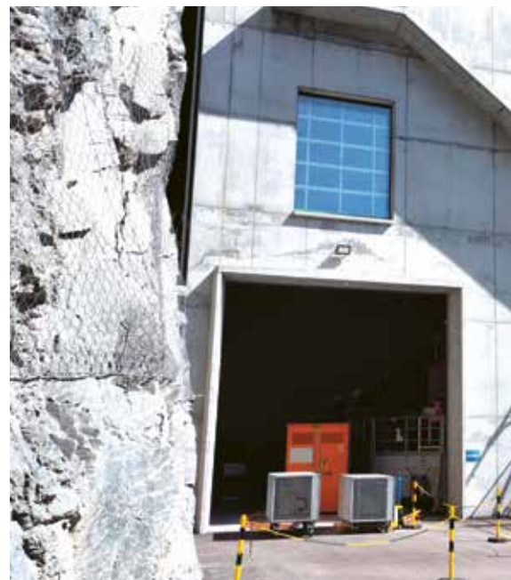
Durant les essais de fonctionnement en îlotage, des appareils de chauffage de chantier ont servi de réseau afin que les tests ne doivent pas être effectués sur le réseau de distribution réel.
