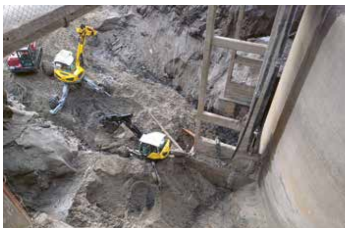
Vue plongeante sur ces travaux de grande ampleur menés par HYDRO. Sicht auf die umfangreichen Arbeiten, die von HYDRO durchgeführt wurden.
