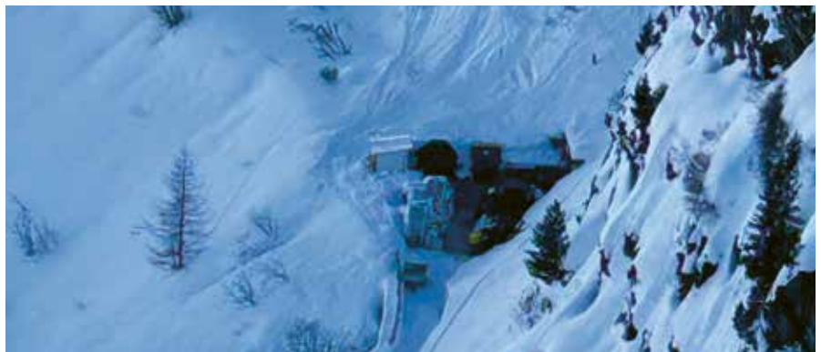
La réhabilitation de la chute de Tsarmette, chantier d'altitude (entre 1560 et 2400 m), a exigé de travailler dans des conditions difficiles, hivernales, avec des accès restreints et des emplacements de travail exigus.
