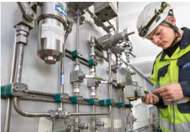
Fabrication, montage et raccordement des commandes hydrauliques des vannes sphériques au répartiteur à Mottec.
