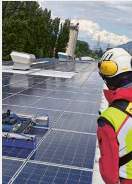
Après nettoyage par un robot, les panneaux solaires de nos Ateliers centraux ont enregistré une production supérieure à celle des trois dernières années.
