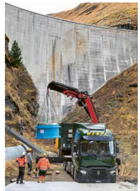
Die Teile der neuen Drosselklappe werden vor dem ersten Schneefall an der Talsperre von Moiry abgeladen.
