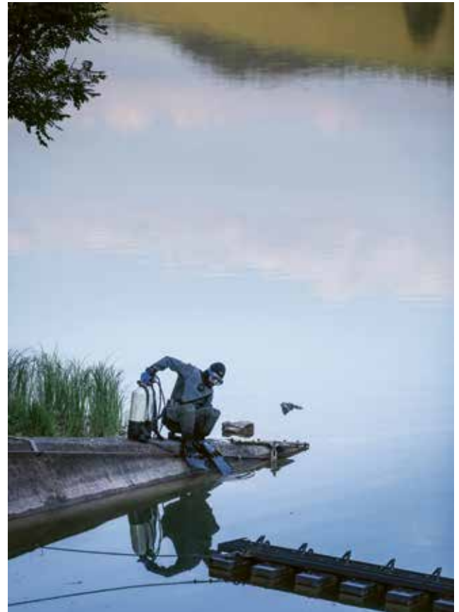
Un plongeur est mobilisé pour mettre en place les batardeaux (digues provisoires), nettoyer et contrôler les glissières de la vanne, assurant ainsi l'étanchéité de la vanne d'entrée.
