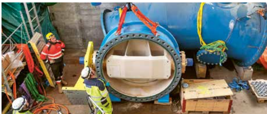
Die Drosselklappe von Tsarmette wurde ersetzt.
