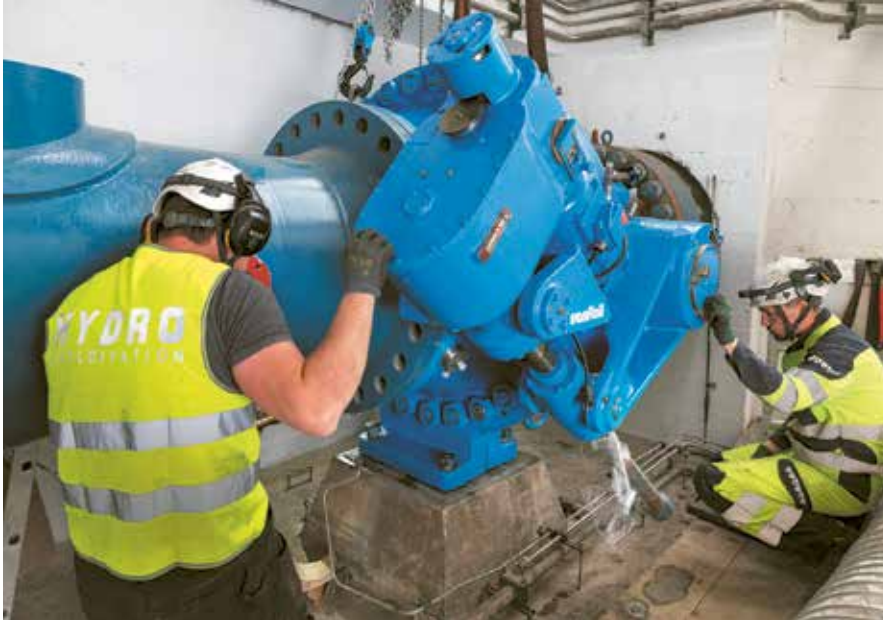
Der von uns revidierte Schieber Nr. 4 wird in Mottec auf den Verteiler montiert.
