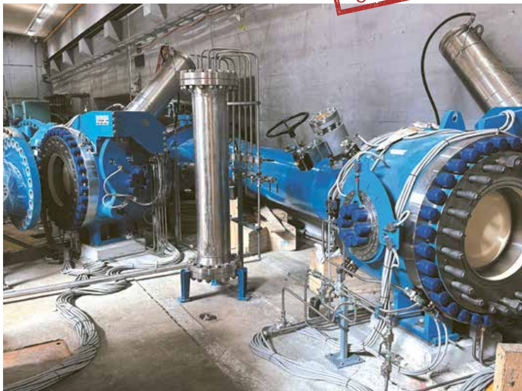
Le nouveau répartiteur et les deux vannes sphériques sont mis en place sur le groupe 1.
