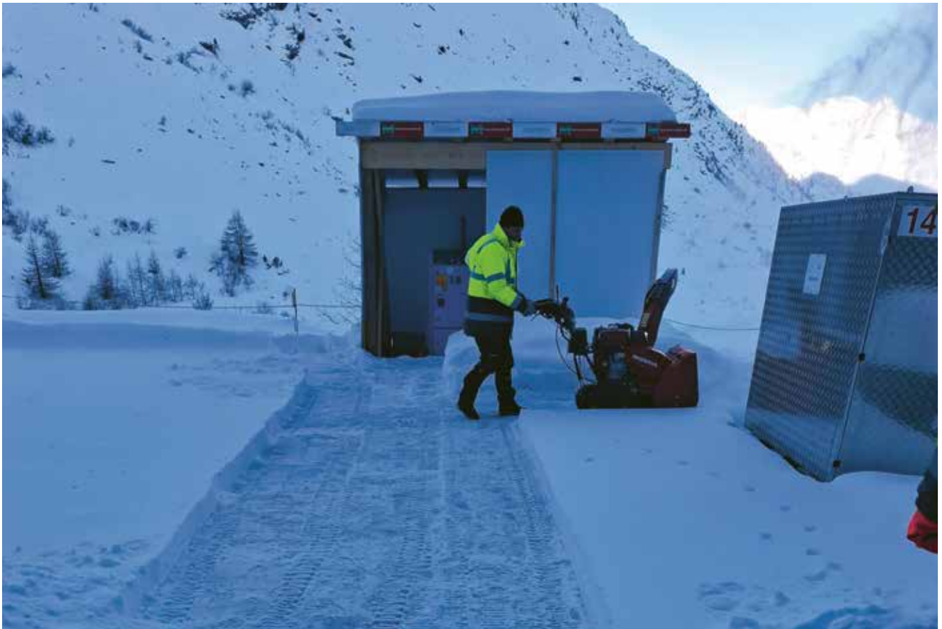
Mitten im Winter mussten die Mitarbeitenden von HYDRO unter schwierigen Bedingungen den Ort vorbereiten, um die umfangreichen Sanierungsarbeiten erfolgreich durchzuführen.
