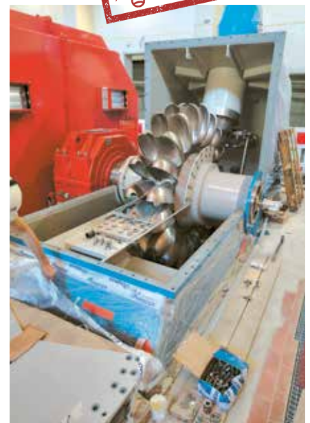
Das neueste Material, der Generator und die Turbine der Gruppe 1, wird montiert.
