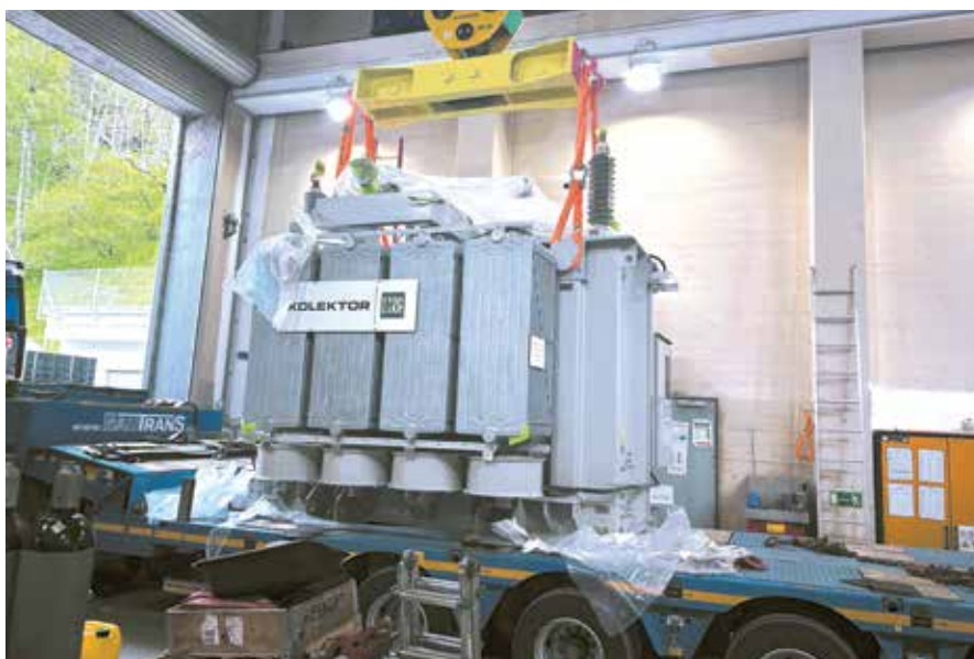
Lieferung des neuen Trafos der Gruppe 1.
