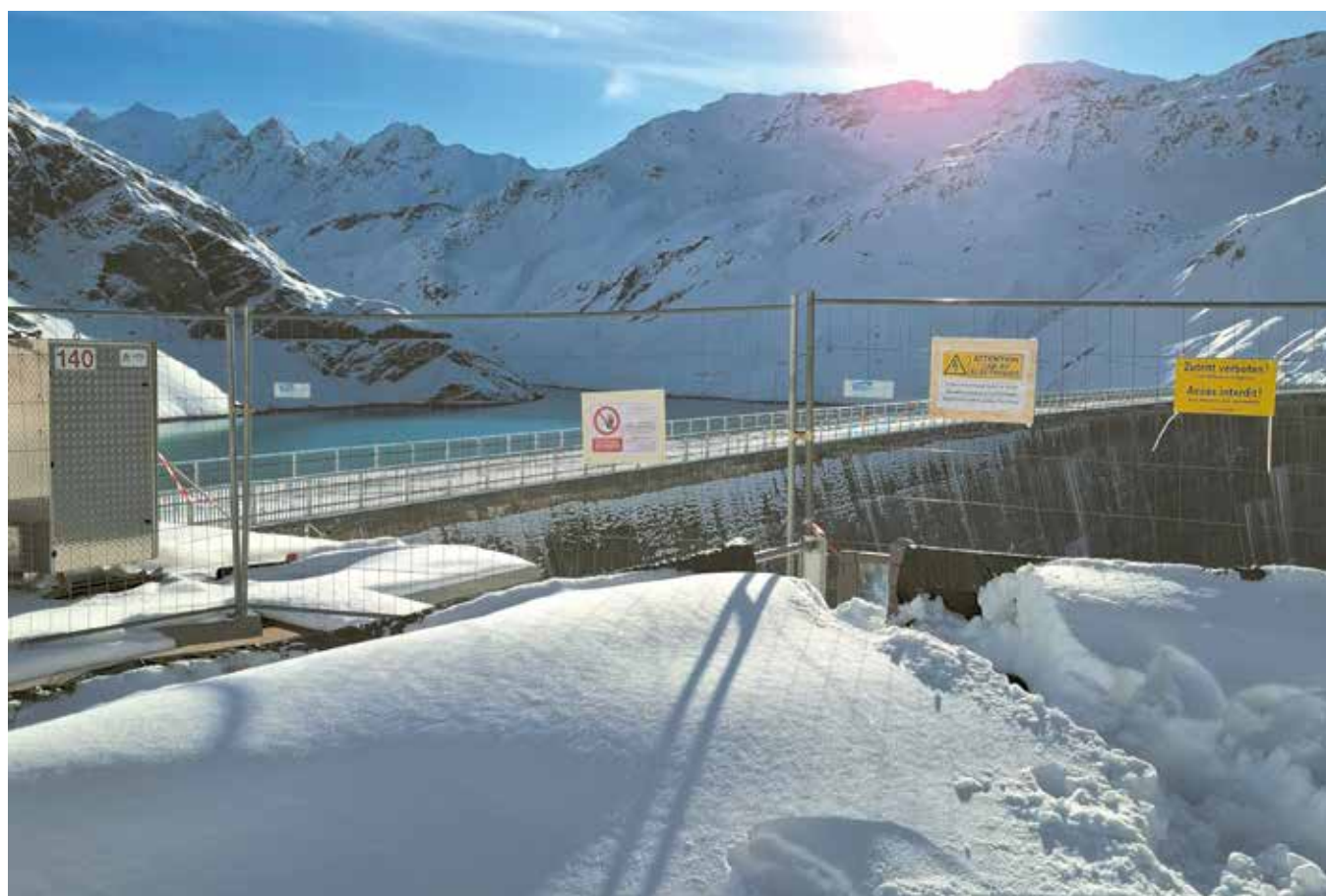
Les lieux d'accès, comme sur le barrage de Moiry, propriété des Forces Motrices de la Gougra, sont systématiquement sécurisés et une signalétique spécifique est installée.
