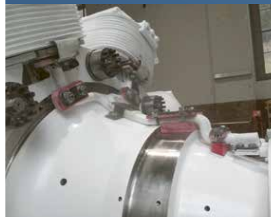
Les connexions entre les bagues et les pôles ont été entièrement renouvelées.
