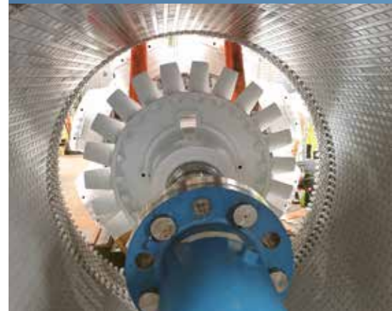
Nach Abschluss der Generatorrevision wurde der Rotor wieder in den Stator eingeführt.
