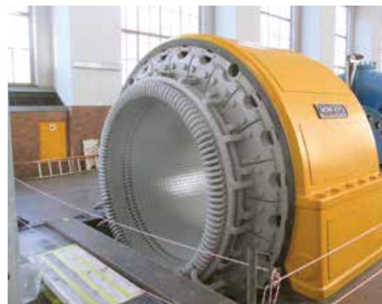
Le bobinage stator a été entièrement nettoyé, et les différents vernis refaits par la suite.
