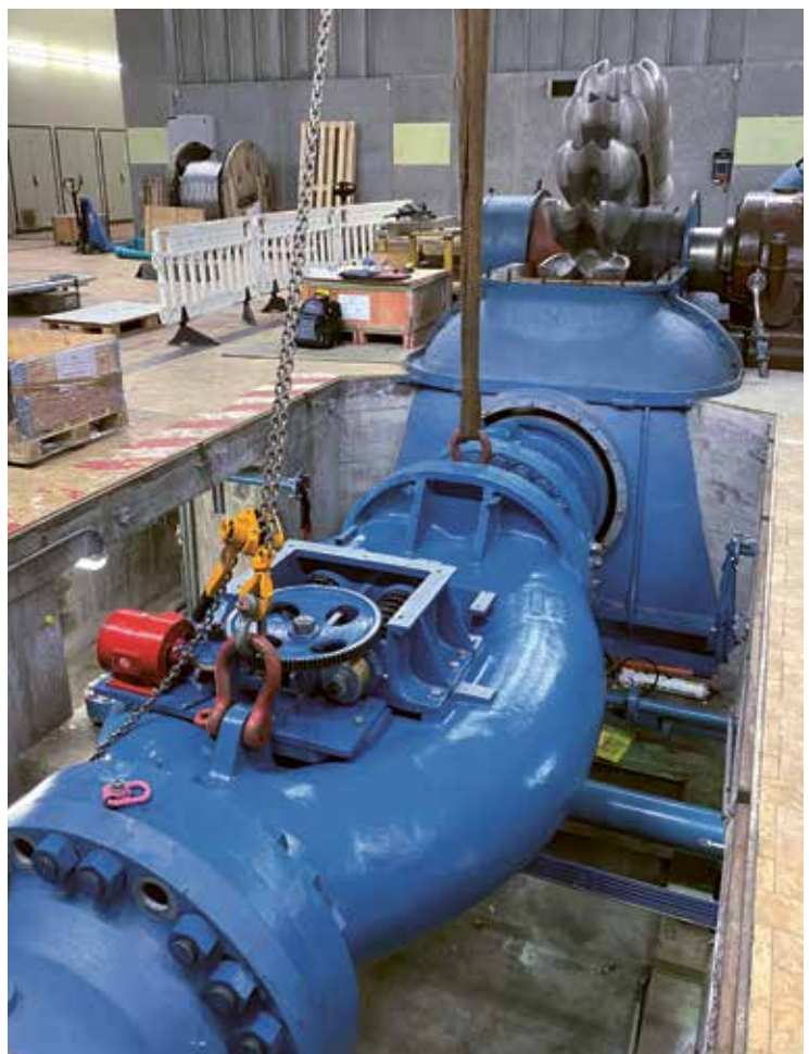
Die Einspritzdüse – 15 Tonnen schwer und 5,5 Meter lang – wird eingerichtet, um die Messungen durchzuführen. Sie ist so zu positionieren, dass der Strahl das Rad an der gewünschten Stelle trifft.
