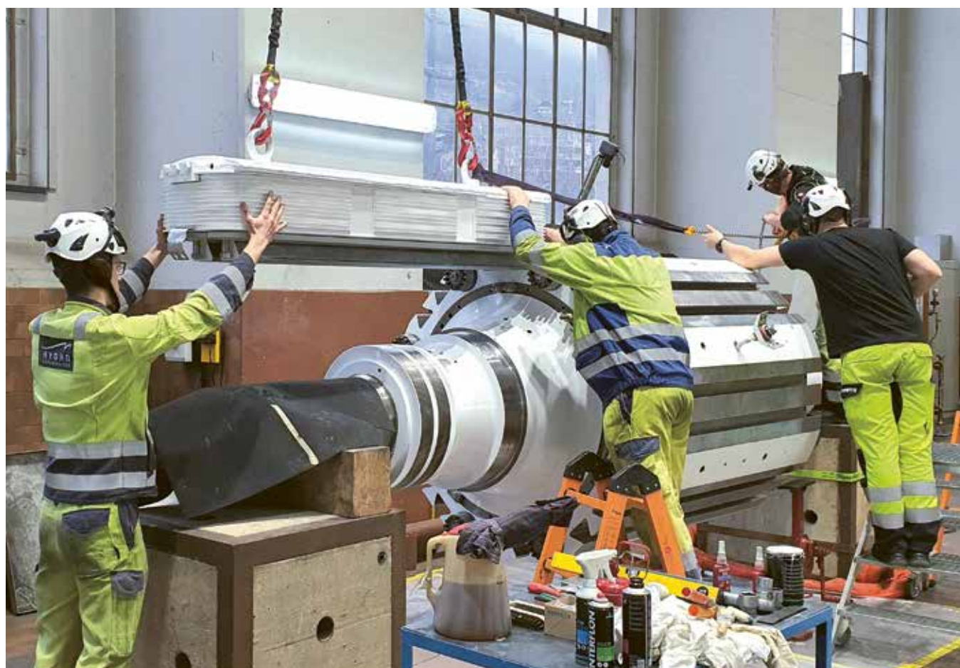
Après leur réhabilitation, les pôles sont remontés.
