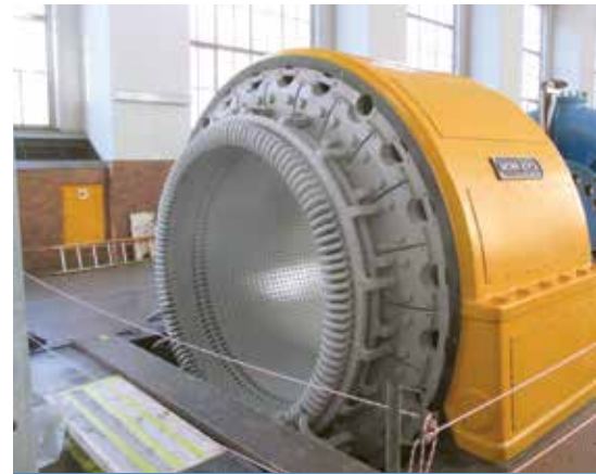
Nach der vollständigen Reinigung der Statorwicklung wurden die verschiedenen Lacke erneuert.
