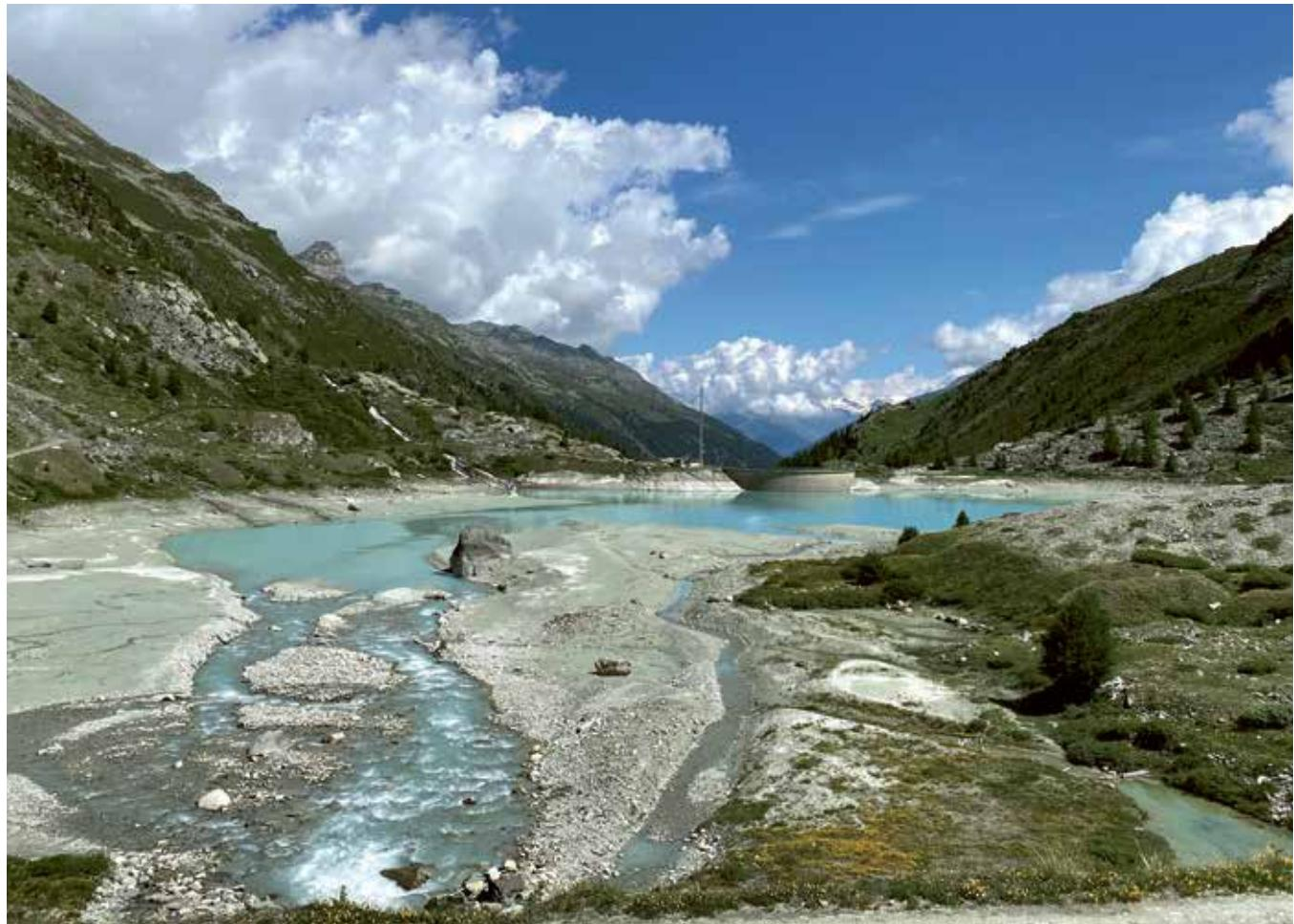
Der Turtmann-Stausee hoch oben im gleichnamigen Oberwalliser Tal verfügt trotz vieler eigener Zuflüsse über eine geringe Kapazität. Sein Wasser wird daher durch das Kraftwerk von Mottec im benachbarten val d'Anniviers verwaltet. Es sorgt dafür, dass das Wasser des Turtmannsees zum Stausee von Moiry mit einem 100-mal grösseren Stauvolumen (77 Mio. m<sup>3</sup>) gepumpt und dort turbiniert wird.
