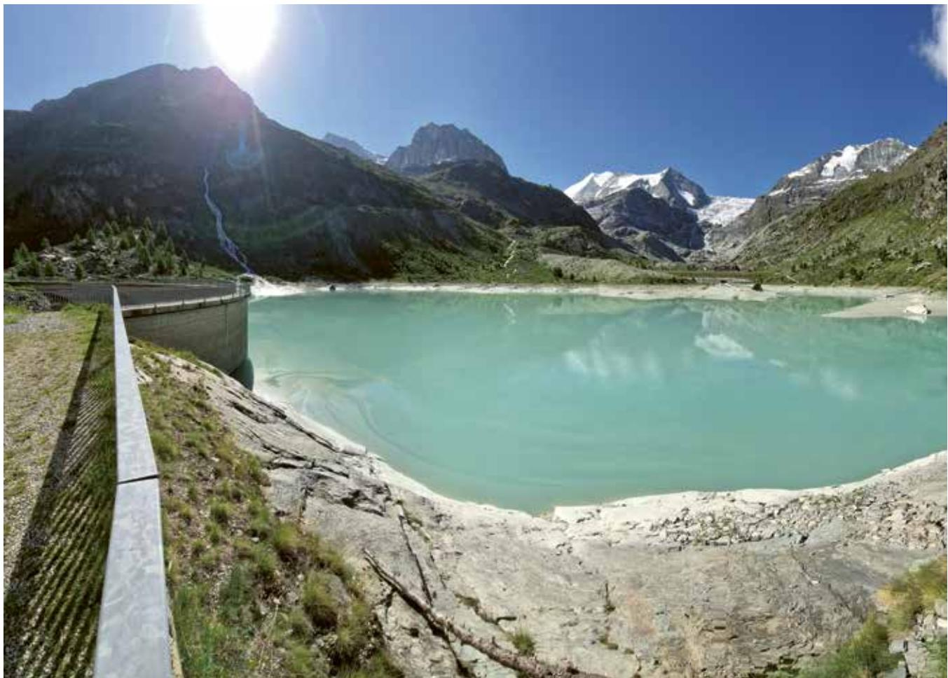
Le barrage de Tourtemagne, au fond de la vallée du même nom, dans le Haut-Valais, dispose d'une petite capacité par rapport aux apports propres. Sa gestion se fait donc via l'usine de Mottec, dans la vallée voisine d'Anniviers. Celle-ci assure en effet le turbinage et le pompage des eaux de Tourtemagne vers le barrage de Moiry, qui dispose d'une retenue 100 fois supérieure (77 mios de m<sup>3</sup>).
