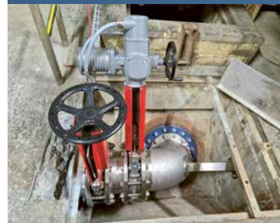
Ein neuer automatisierter Bypass-Schieber wurde in die frühere Dotationszone der Grundablasskammer eingebaut.
