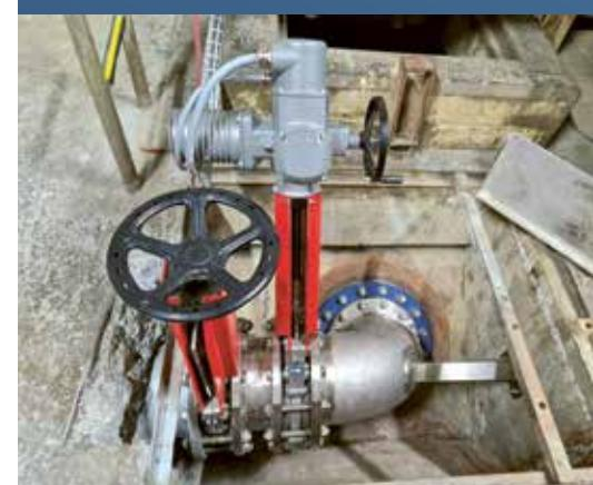
Une nouvelle vanne automatisée dotée d'un by-pass a été installée dans l'ancienne zone de dotation située dans la chambre de la vanne de fond.
