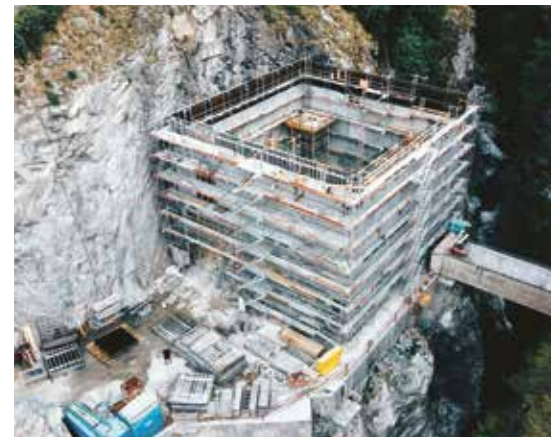
Der Bau des neuen Kraftwerks schreitet voran (22. August 2022).
