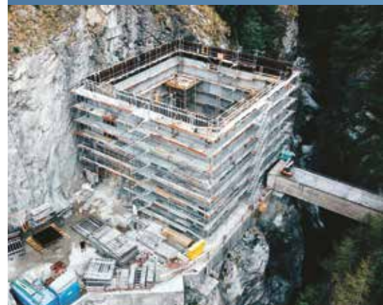
Avancement de la construction de la nouvelle centrale (22 août 2022).
