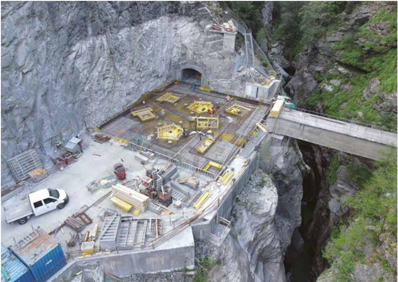
Bodenarmierung des neuen Kraftwerks (14. Juli 2022).
