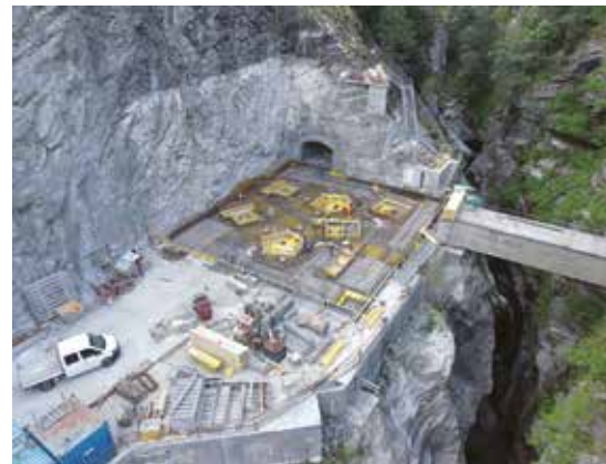
Ferraillage de la dalle de la nouvelle centrale (14 juillet 2022).
