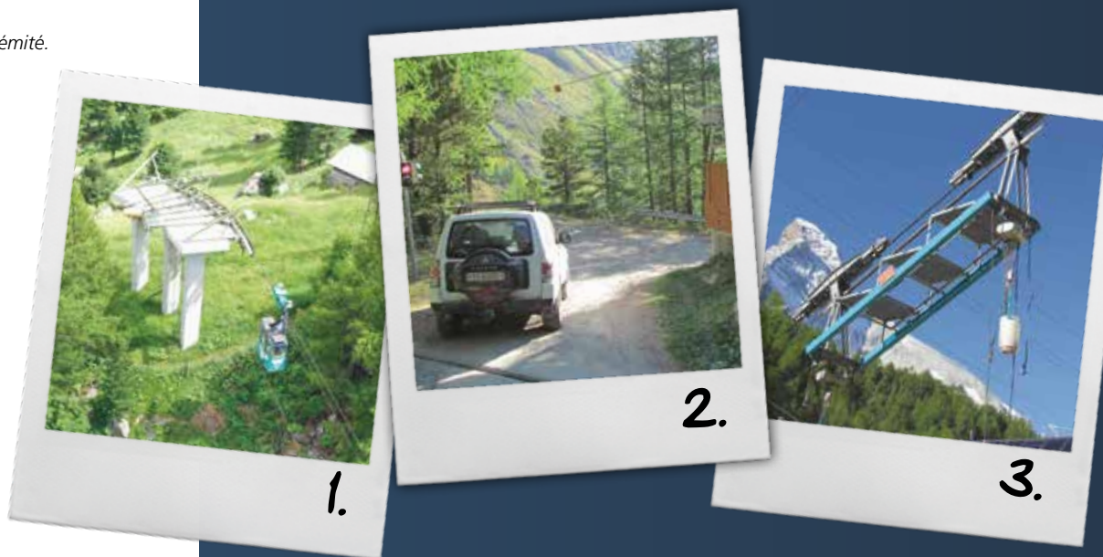
Pyl ne angulaire avec d viation de 31 . En poss der deux sur son trac  fait de ce téléphérique une raret  en Europe.
