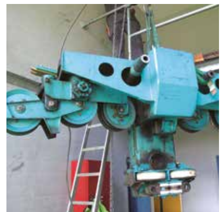
Das Laufwerk der Zmutt-Seilbahn wird für eine Revision demontiert.
