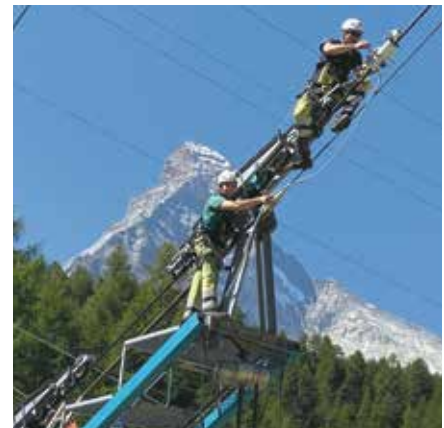
Adrian Sarbach et André Inderbinen, du GEH Zermatt, placent l'appareil de lubrification des câbles sur un câble porteur, sous le regard du Cervin.
