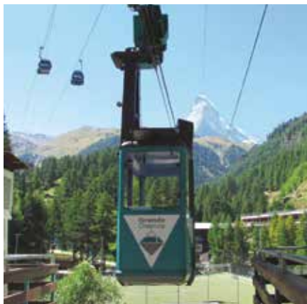
Kabine für den Personentransport der Seilbahn Winkelmatten–Zmutt.
