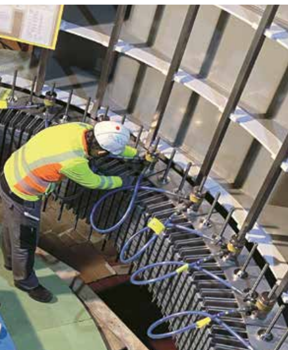
Février 2023: préparation des presses hydrauliques pour le premier pressage de l'empilement des tôles du stator. Le personnel du GEH Massa-Goms épaula le personnel du fournisseur dans cette opération.
