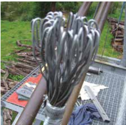
Das Zugseil ist bereit f r das Vergiessen des Vergusskopfes.
