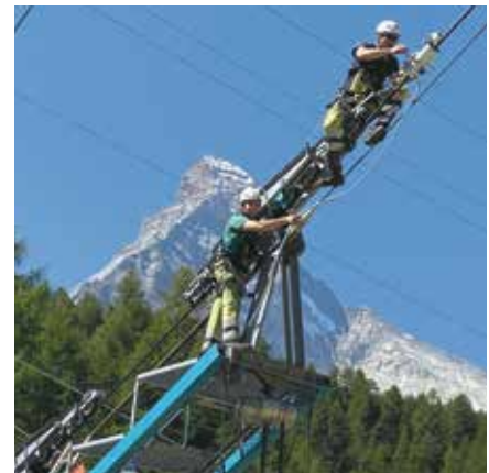
Vor der herrlichen Kulisse des Matterhorns richten Adrian Sarbach und André Inderbinen von der GEH Zermatt den Seilschmierapparat auf einem Tragseil ein.
