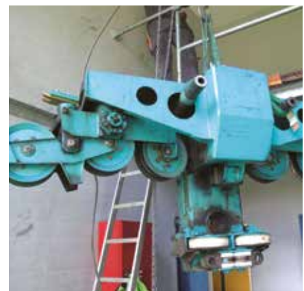
Le mécanisme de roulement du téléphérique de Zmutt est démonté pour être révisé.
