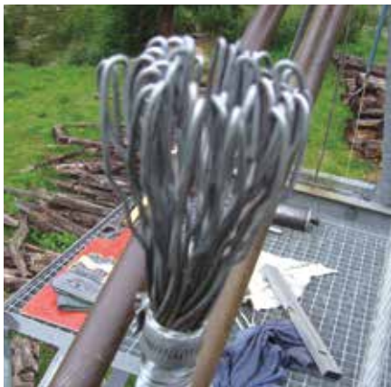
Le c ble tracteur est pr t pour le scellement de l'extr mit .
