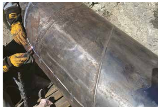
Intervention an der Druckleitung des Kraftwerks Leteygeon.
