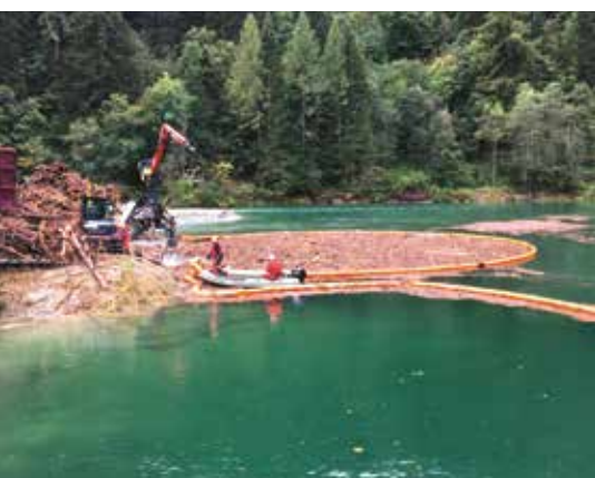
Après l'extraction des troncs par une entreprise spécialisée, l'utilisation d'un « bras d'huile » a permis de récolter en un temps record les branches restantes.
