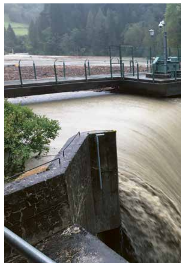
Le passage de la tempête Alex, les importantes pluies et le fœhn ont provoqué en octobre 2020 des débits extraordinaires dans le Haut-Valais, et d'importantes chutes d'arbres qui auraient pu endommager les aménagements.
