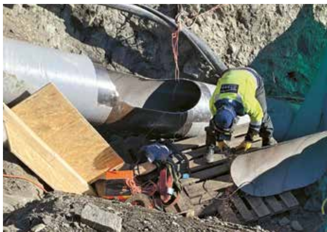
Intervention sur la conduite forcée de la centrale de Leteygeon.
